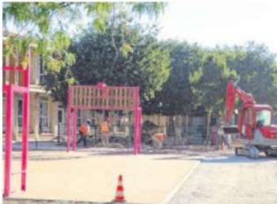
La cour en plein travaux. /PHOTO J.R.
